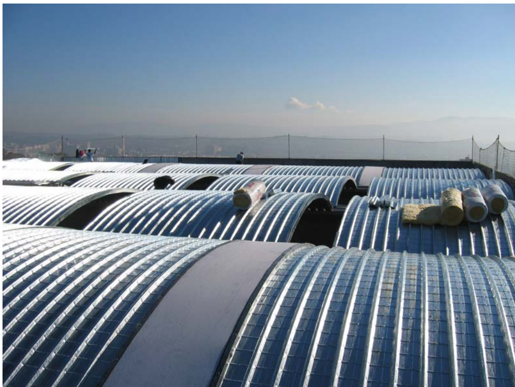
Imagen 4. Fase de montaje de cubierta curvada autoportante formada por el perfil INCO 44.4 Curvado
