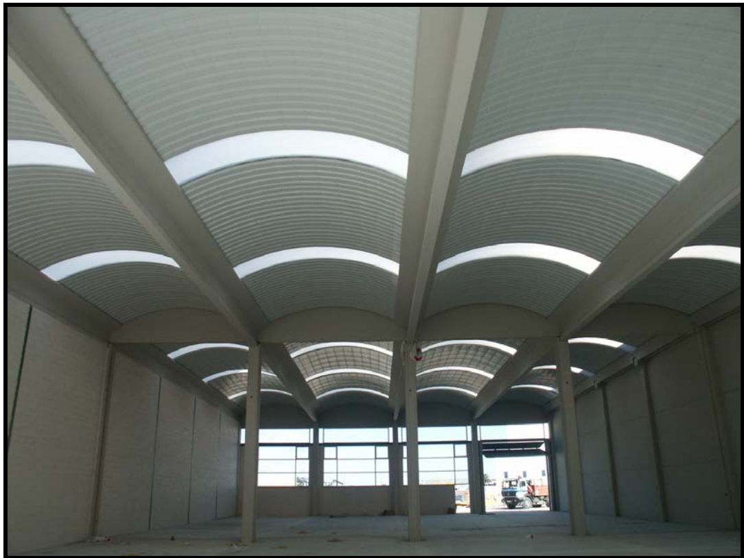
Imagen 5. Cubierta curvada autoportante formada por doble perfil INCO 44.4 Curvado y lucernario doble
