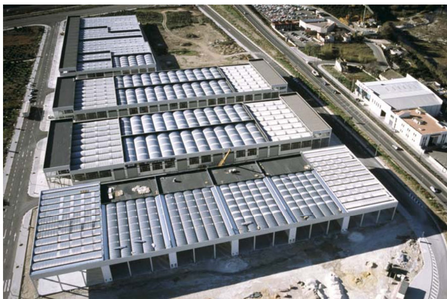
Imagen 1. Nave industrial cuya cubierta esta compuesta por el perfil INCO 44.4 Curvado
