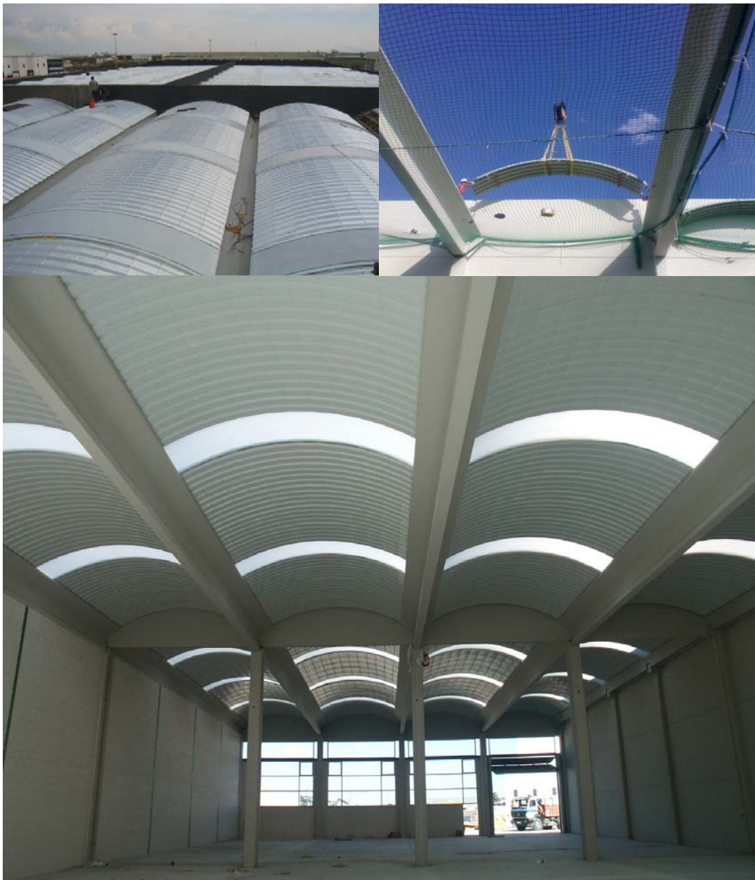
Imagen 6. Diferentes obras de cubiertas curvadas autoportantes.
