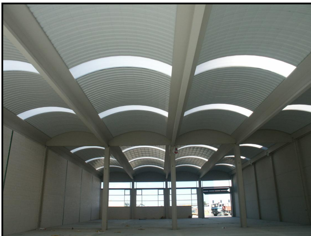
Image 5. Toiture courbée autoportante formée d'un double profil INCO 44.4 Courbé et double lanterneau
