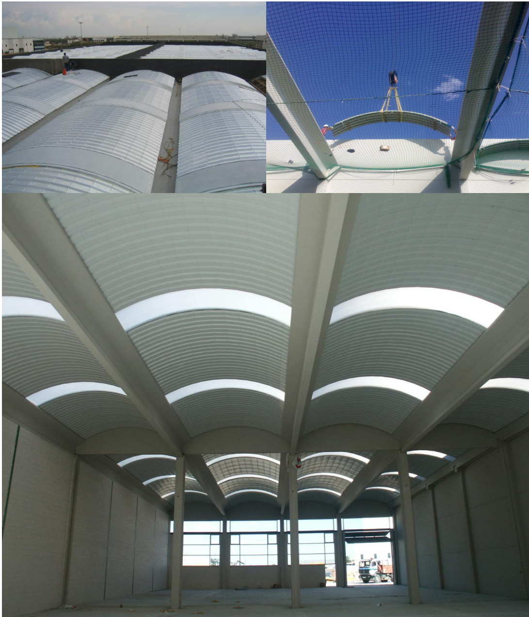
Image 6. Différentes Toitures Courbées Autoportantes.
