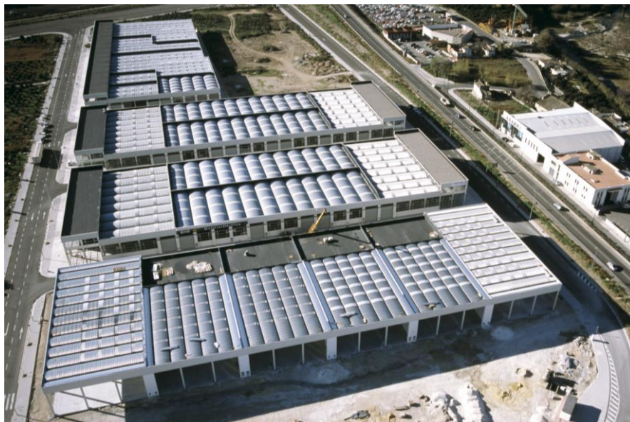
Image 1. Usine dont la toiture est fabriquée avec le profil INCO 44.4 Courbé
