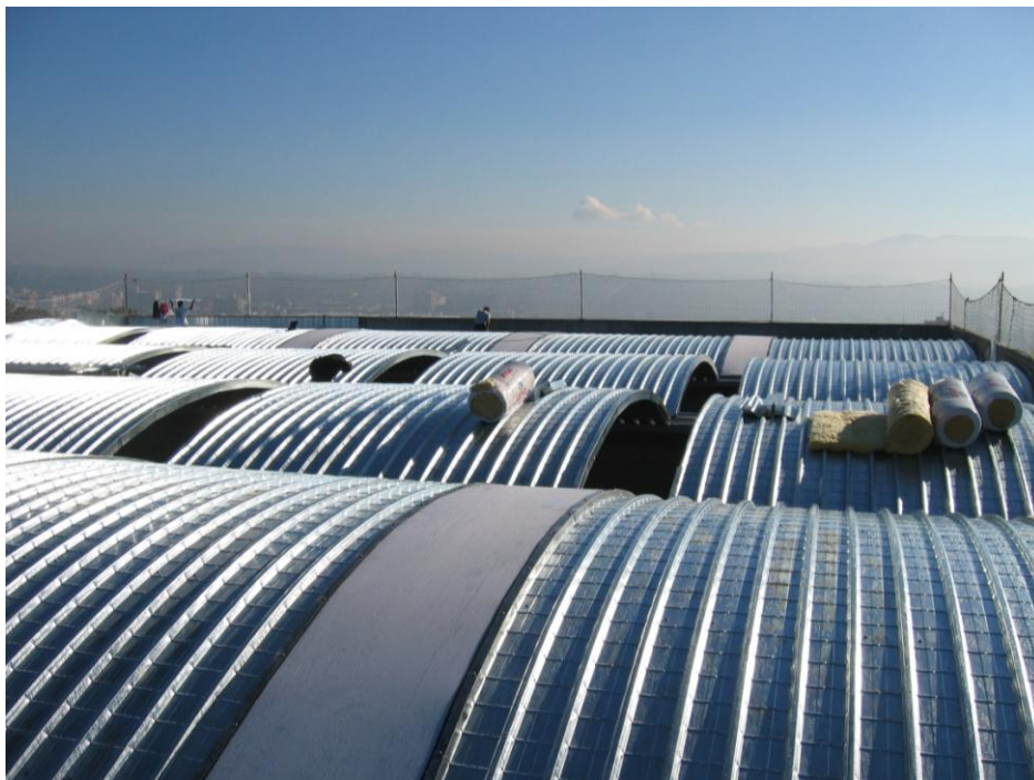
Image 4. Phase de montage de toiture courbée autoportante constituée du profil INCO 44.4 Courbé
